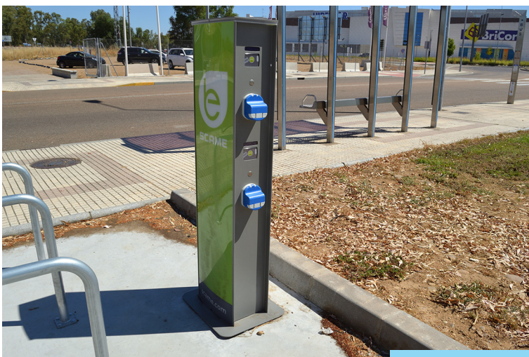
Imagen 26. Izqda.: Estación de recarga lenta con varias tomas para la recarga de bicicletas y ciclomotores eléctricos. Excmo. Ayto. de Badajoz. Dcha.: Punto de recarga lenta vinculada en origen. Parque móvil de la Excm. Diputación Provincial de Badajoz.
