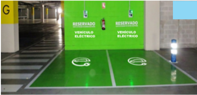
Imagen 33. Señalización horizontal para aparcamientos de acceso público.
